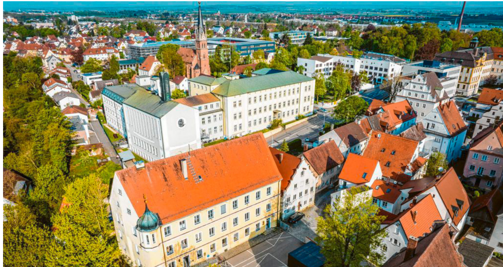
Die Akademie für Lehrerfortbildung braucht weitere Räume, sie übernimmt das Gebäude des früheren Gesundheitsamts in der Weberstraße 14 (Vordergrund). Fotos: Jan Koenen, Stadtverwaltung; ALP
